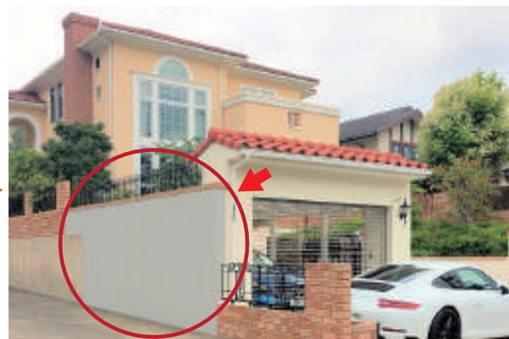
＜施工後1年後＞施工直後と全く変わらず、汚れ筋が見当たらない。
