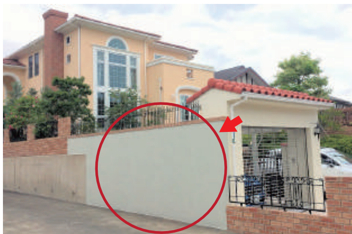
＜施工後＞壁面を塗装後、ビアンコート外壁用(超疎水タイプ)を塗布した。
