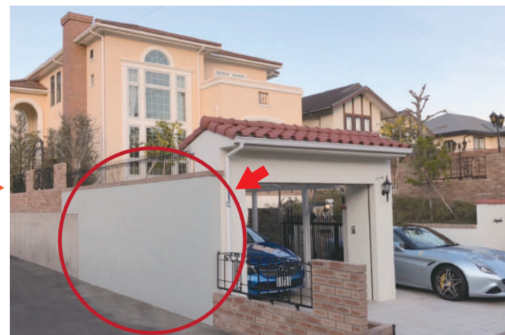
＜施工後2年＞2年経ってもセルフクリーニング効果が持続して汚れない。
