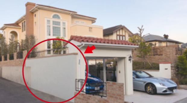
ひと筋の雨だれもなく、施工時の光沢を保っている
